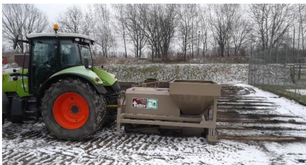
Einbau von rohrlosen Dränageschlitten bei einem Hockeyfeld in Bautzen 2018.
