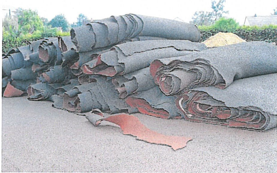
Die alte Laufbahn wird per Bagger abgeschabt, sie sammelt sich in großen Rollen.
