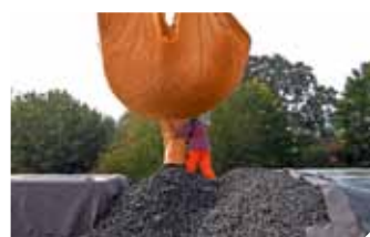
Einbau mit Abladetüchern
